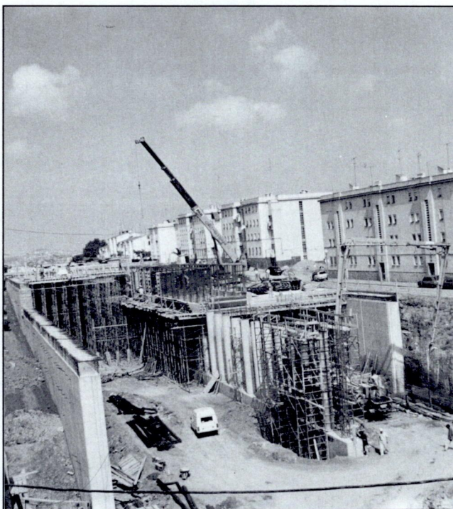
Obres del 2n Cinturó
