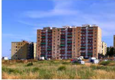
Blocs d'habitatges anys 60-70
