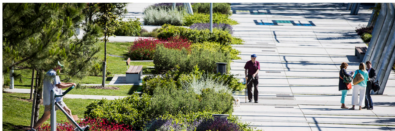
Elements de drenatge sostenible que permeten difondre l'aigua pluvial al sòl. ©Robert Ramos
