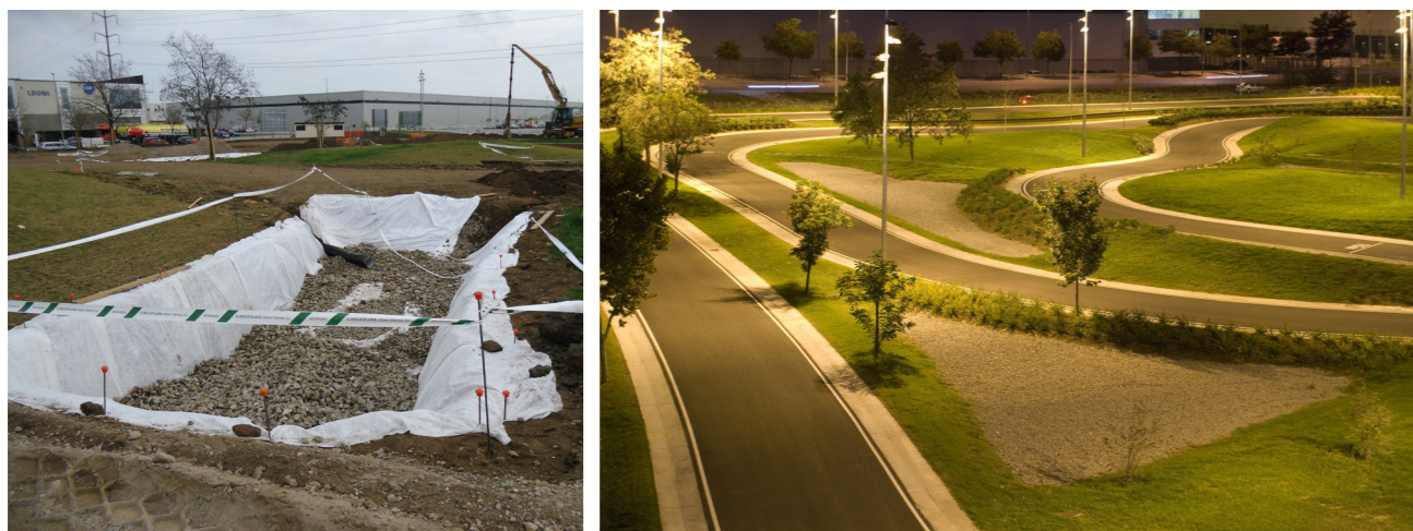
Excavacions amb graves per difondre aigua al sòl i subsòl, i pous de drenatge fins al nivell freàtic
