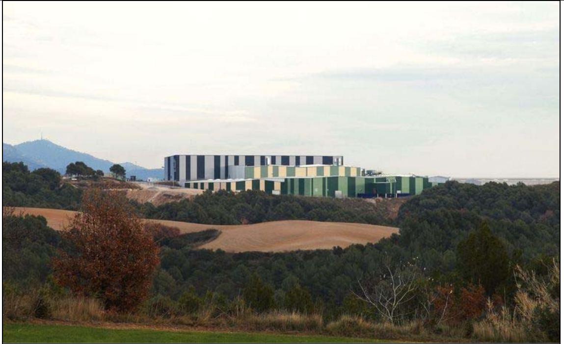
Figura 5. Vista en alzado del conjunto de edificios, que resalta la posición más elevada de la nave de recepción respecto del resto
