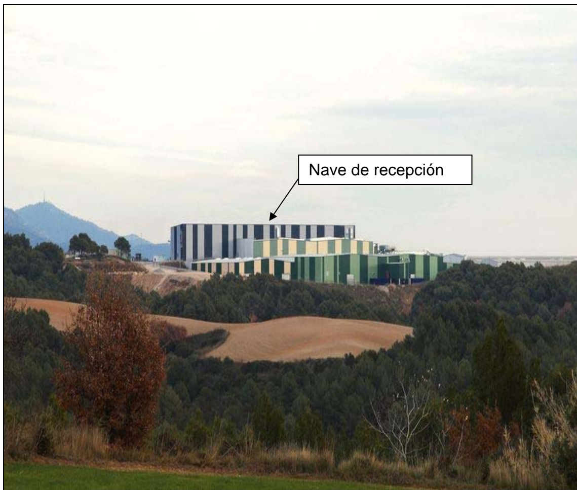
Figura 20. Perspectiva del edificio de recepción que resalta su posición elevada respecto al resto de naves.
