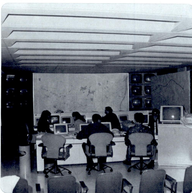
Centre de Control de Tràfic
