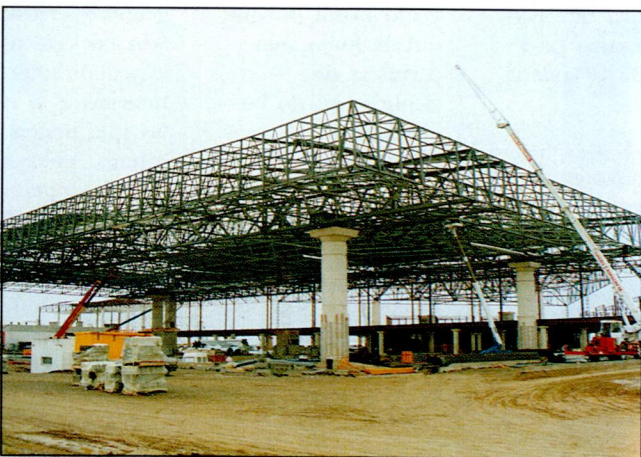
Terminal de internacional, estado de las obras.14 de junio del 90
