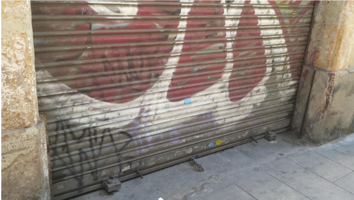
Vies per posar estructura de protecció a finca del carrer Marques de Barberà, Barcelona (GAMA)
