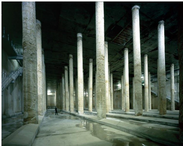
Fotografia del dipòsit pluvial del Parc Joan Miró (Font: BCASA)
