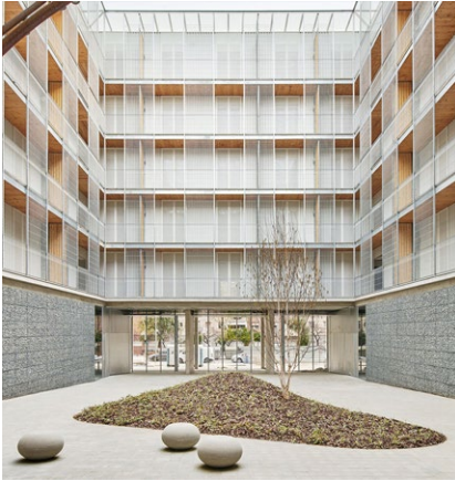
86 homes in Cornellà de Llobregat
