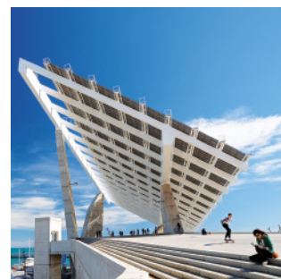
Transició energètica: placa fotovoltaica al Fòrum de Barcelona © Antonio Lajusticia
