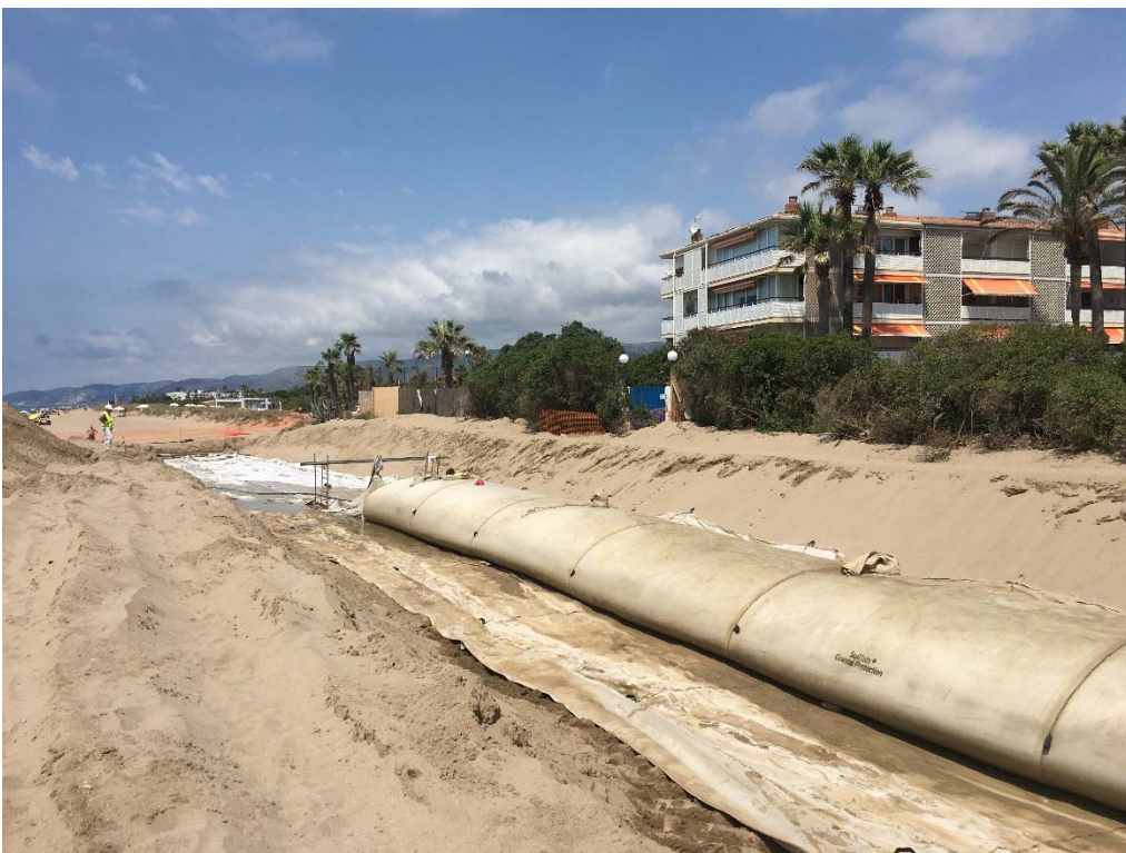
Figura 71. Col·locació del tub de geotèxtil a la platja de Gavà
