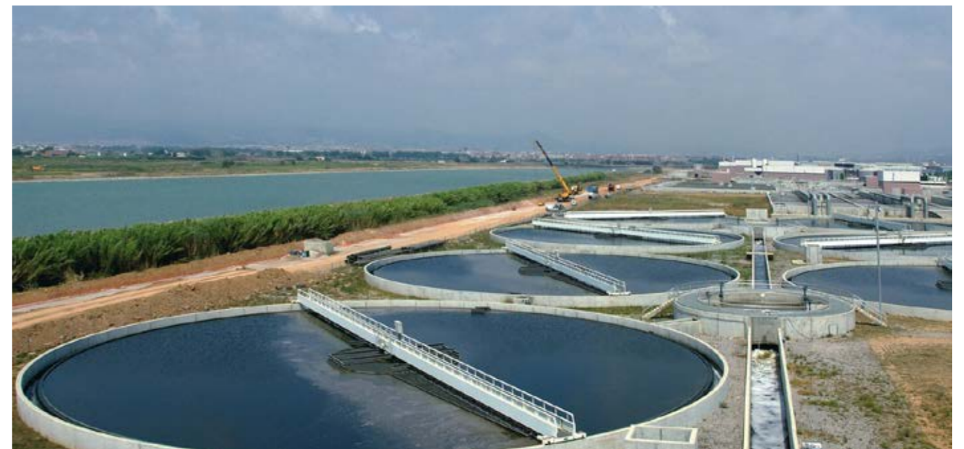
El Prat de Llobregat WWTP.
