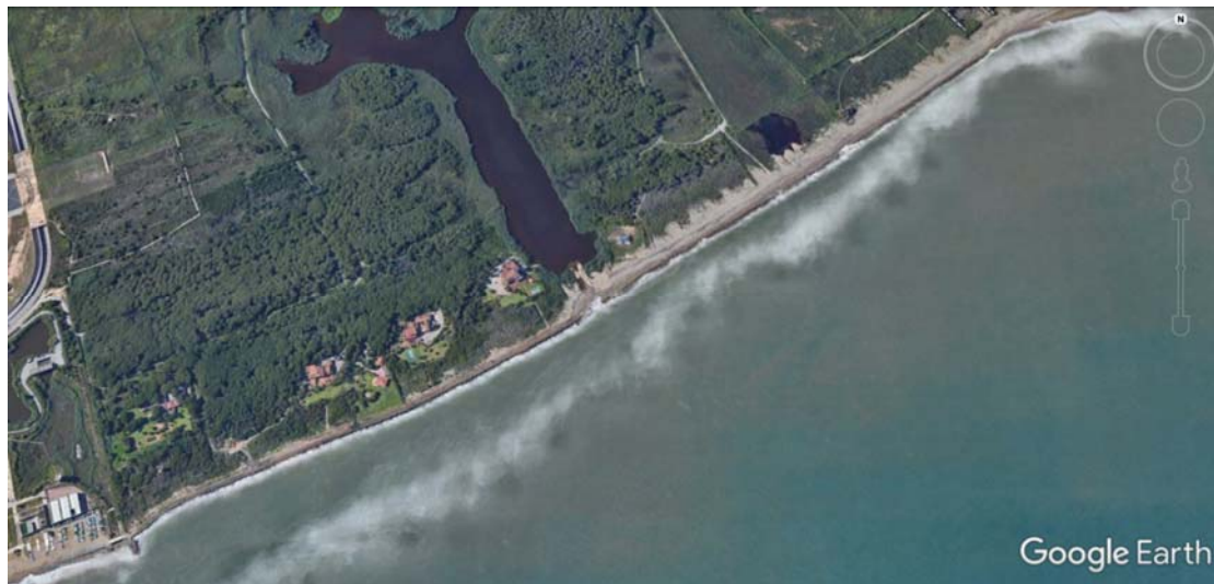
Figura 37. Configuració actual de la vora costanera des de la Caserna dels Carabiners fins a l'Escola de Vela del Prat (2020)
