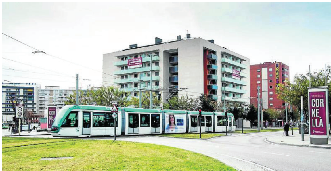
Edifici promogut per l'IMP SOL a l'avinguda de Sant Ildefons de Cornellà de Llobregat.
