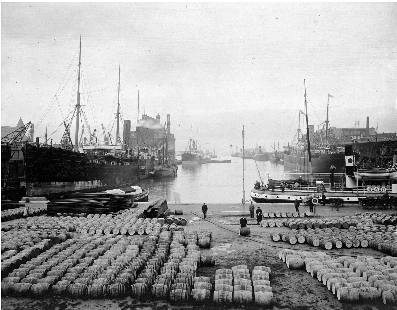
El port al 1904: milers de barrils de diverses matèries primes han estat tancats i esperen ser carregats. Font: Cobe
