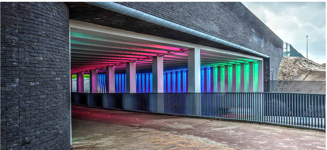
Marstunnel Zutphen, el túnel d'accés ja executat. Font: Frans Blok
