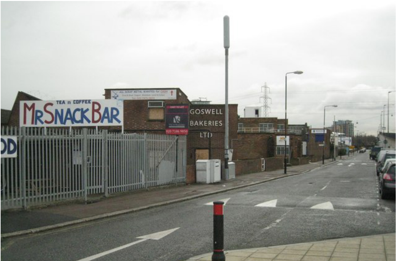
Recinte abans de la rehabilitació. Font: www.geograph.org.uk
