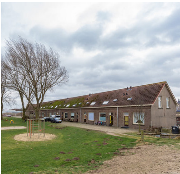
Edifici amb valor històric i cultural a De Mars
