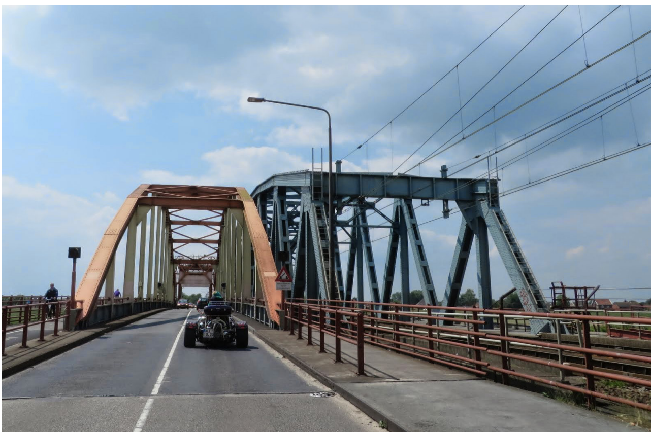
Pont viari i ferroviari sobre IJssel
