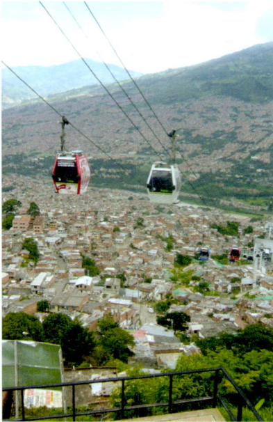
Metrocable, sistema de cable aéreo de transporte masivo, complementario del metro.
