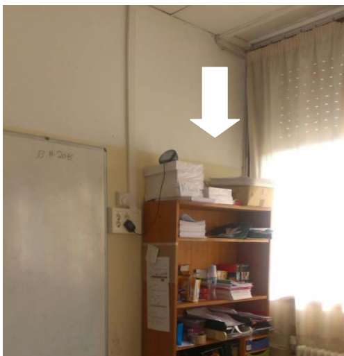
Equip instal·lat a aula sud-oest
