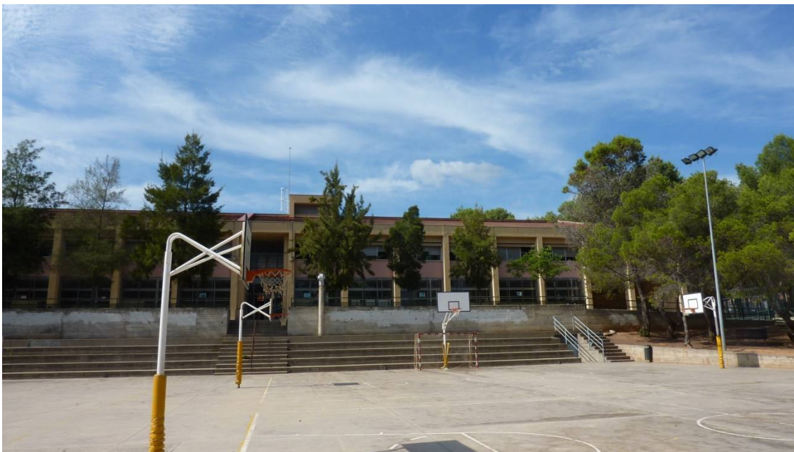
Façana sud-est de l'edifici
