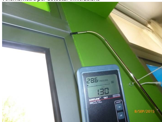
Anemòmetre per detectar infiltracions
