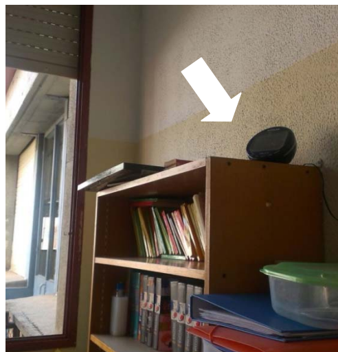
Equip instal·lat a aula nord-est
