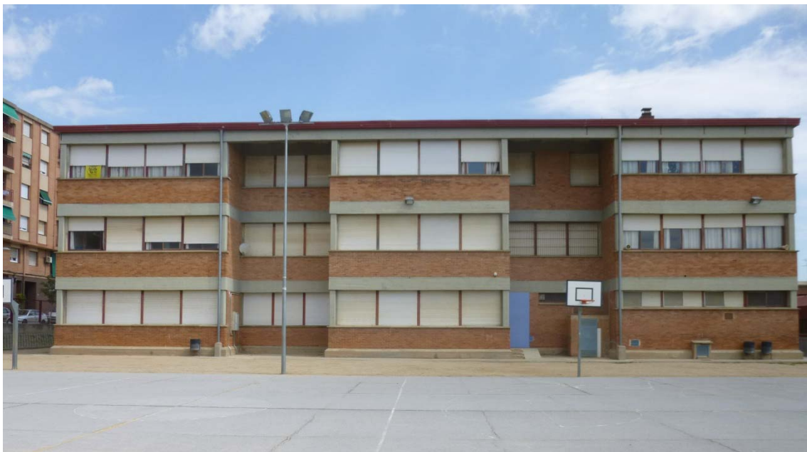
Façana sud-oest de l'edifici
