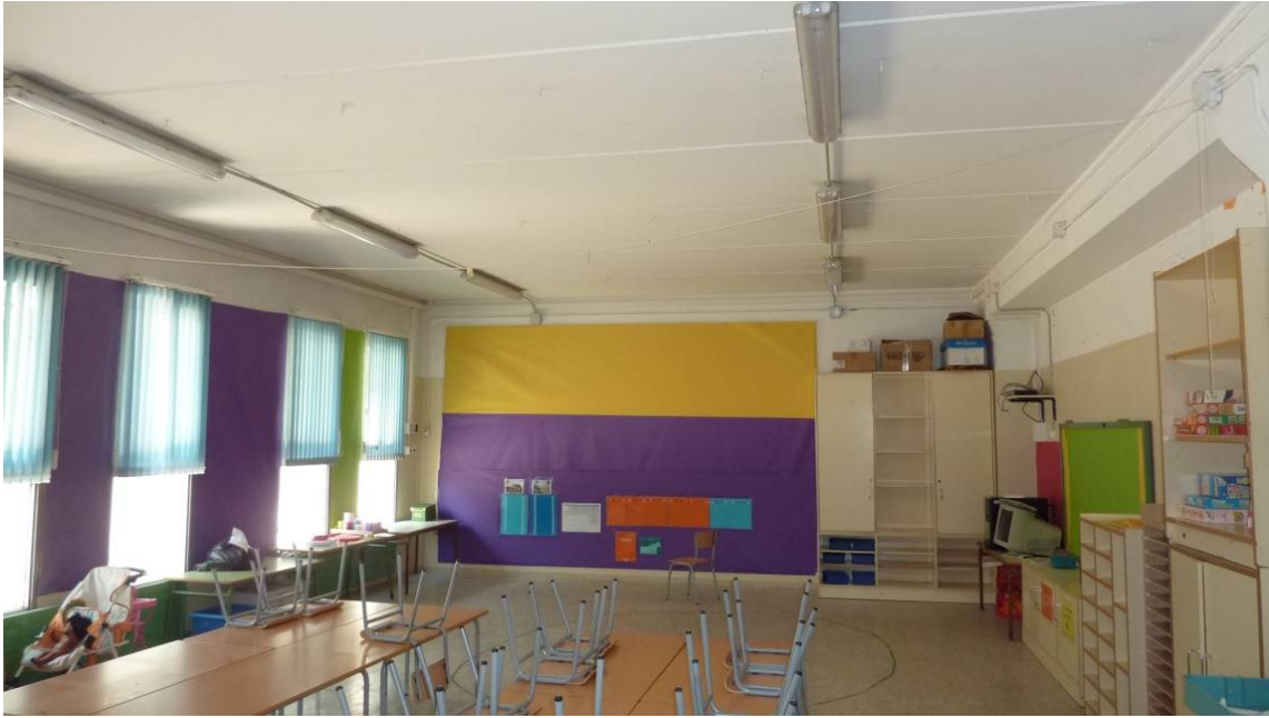
Interior d'una aula en façana nord-oest de l'edifici construït en 1a fase
