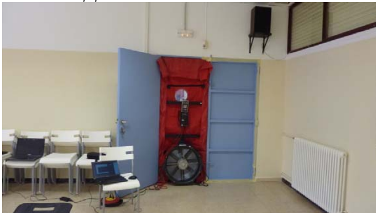
Detecció amb gas tintat
