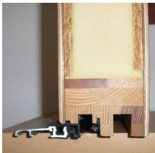
Perfil estanqueïtat a l'aire en paviment (font: Variotec)
