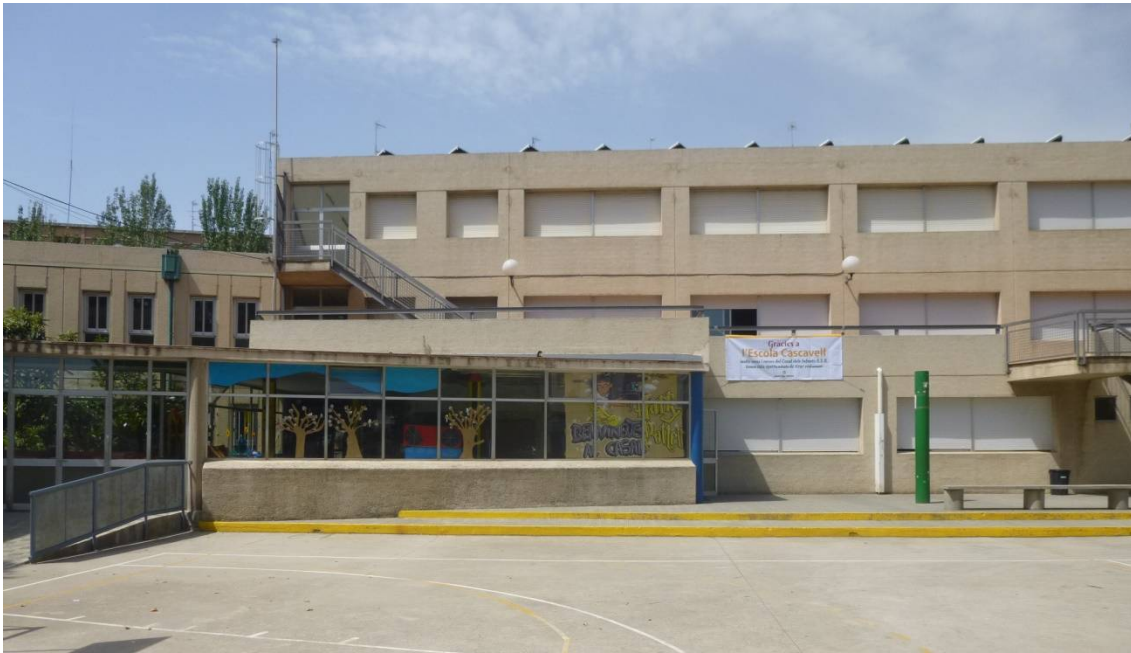
Façana sud-est de l'edifici
