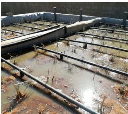
Figura 3.1. Planta pilot de depuració ecològica per al tractament i la reutilització d'aigües residuals, que la UB va inaugurar al gener al campus de la Universitat Gaston Berger de Saint Louis.
