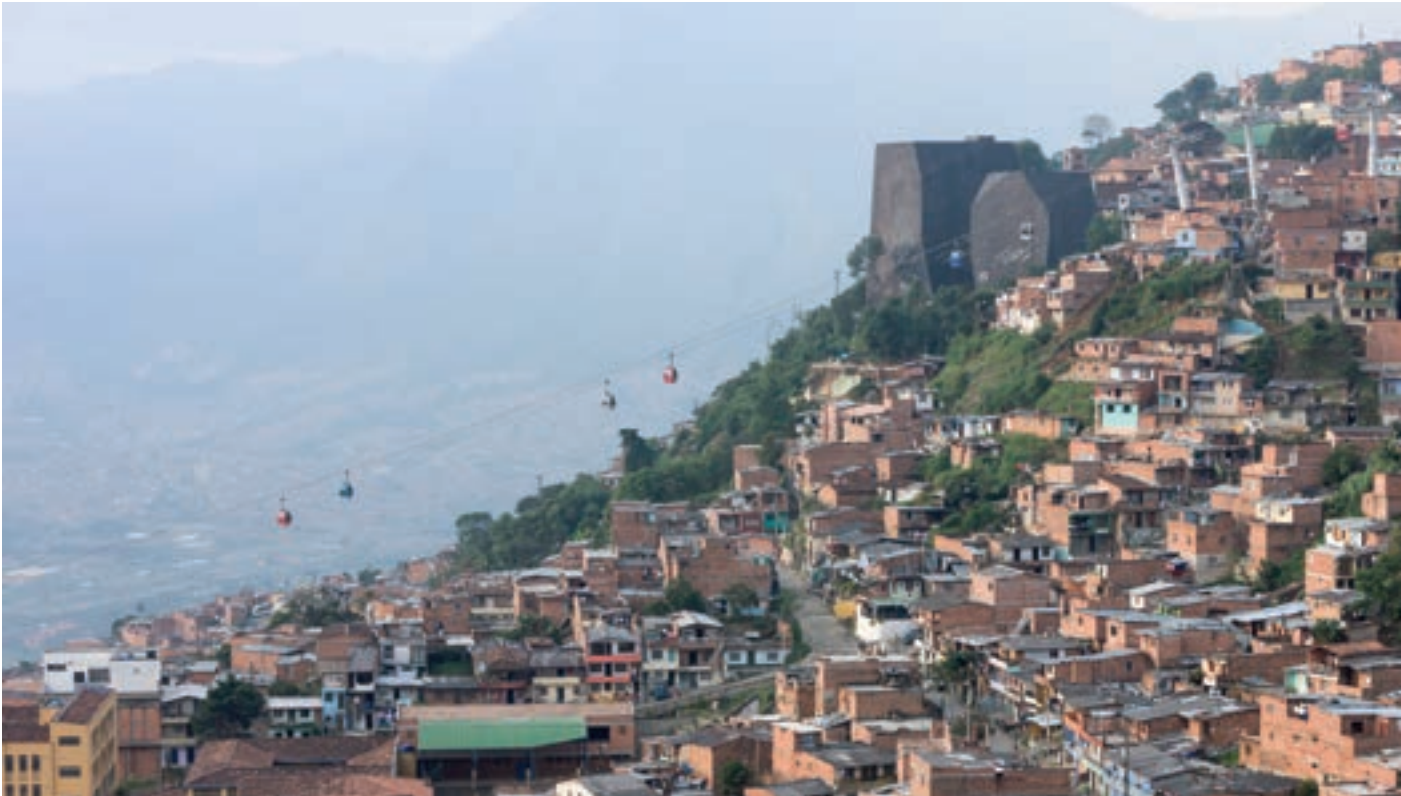
Metrocable at Medellín, Colombia © IWAN BAAN
