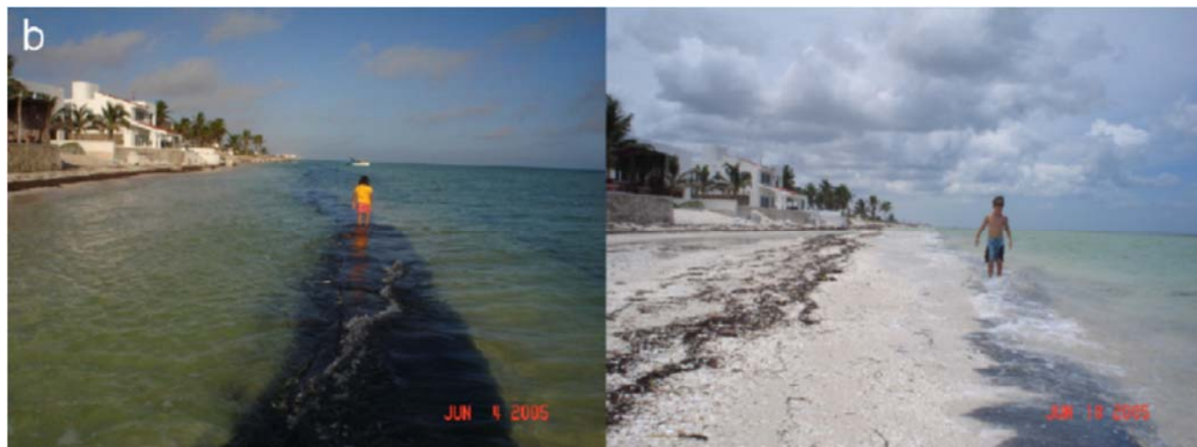
Figura 31. Efecto del dique sumergido de geotubos en la península de Yucatán (Alvarez et al. 2007).
