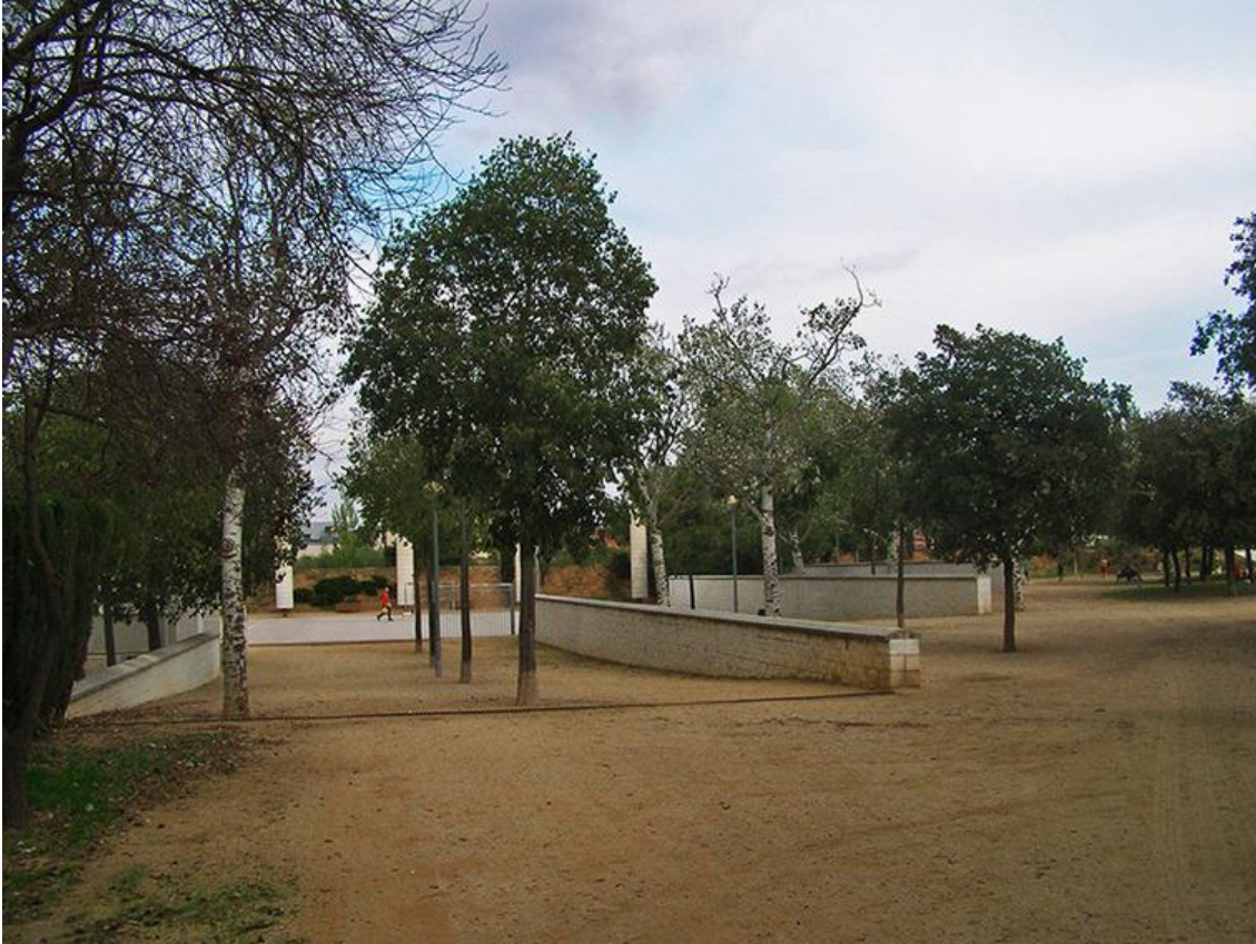
Imatge 15: Murs al Parc del Masot
