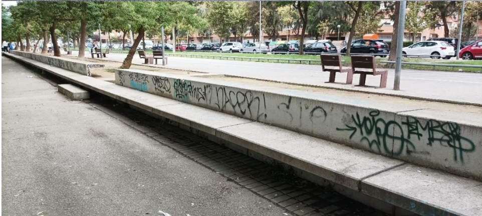
Els bars i terrasses del Passeig dels Ferrocarrils Catalans i de la Carretera del Prat són els més usats per seure en públic. També és força usat per seure el mur que salva el desnivell entre l'Avinguda Baix Llobregat i l'aparcament situat davant l'Institut Martí i Pol.
