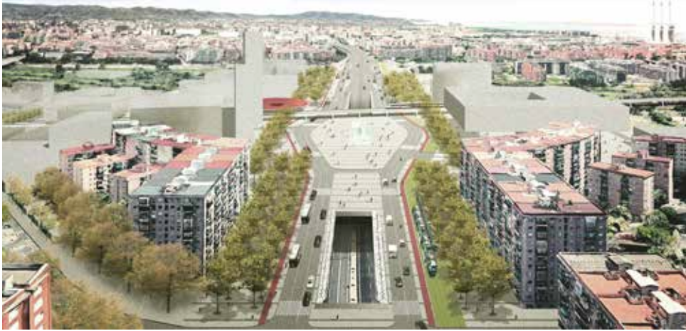
CONTINUITAT DE LES VORERES DE LA GRAN VIA
