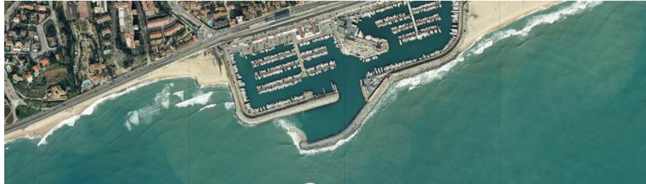
Figura 60. Estat de la bocana del port del Masnou després de l'impacte de temporals significatius recents. Sup.: fotografies després dels temporals de l'01/17, del 12/19 i de l'01/20 (ICGC). Inf.: simulació de la circulació induïda per l'onatge i transport de sediment local als voltants del port del Masnou, sota un temporal de component est amb H_s = 5 m i T_p = 12 s (ECOSOST, 2020)
