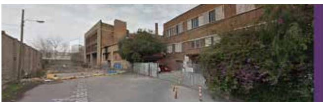
URBANITZACIÓ MOLT DEFICIENT Sector 22a, Sant Adrià de Besòs
