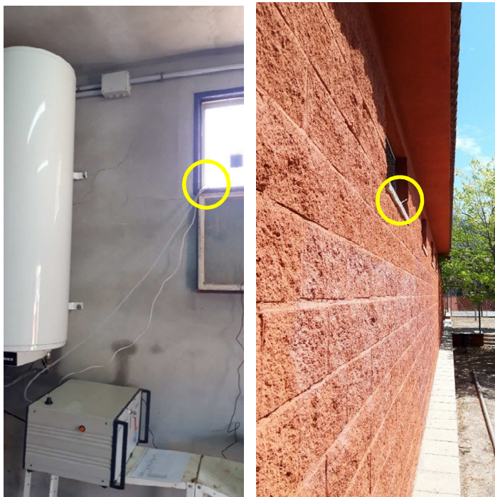
Figura 1. Punt de presa de mostres Collbató (Pistes de Can Dalmasses), equip captador amb sensor automàtic.
