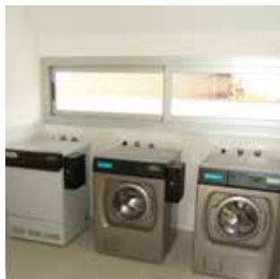
Bugaderia comunitària en un edifici residencial de Mataró Font: Grau i Molist, arquitecte (2010).
