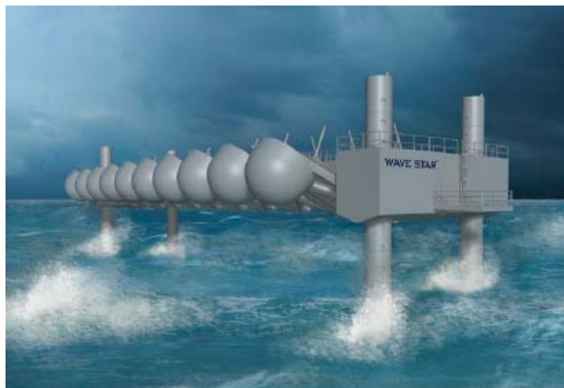
Figura 31. Flotadors apujats per protegir-se de temporals
