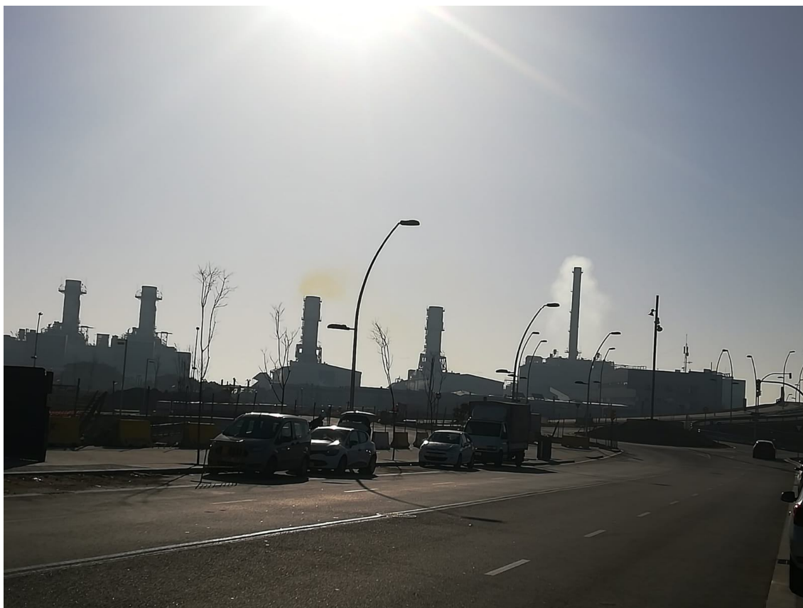
FIGURA 11. Foto que mostra la dispersió restringida de les emissions de la incineradora i central de cicle combinat en condicions d'inversió tèrmica (27 Febrer del 2019).
