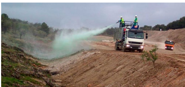
Figura 12. Aplicació d'hidrosembra en el vessant d'un terreny erosionat. Font: Restauración Paisajística, 2018.
