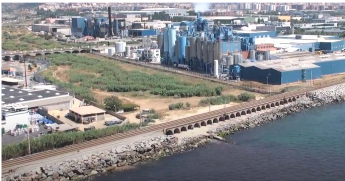
Figura 12. Vista aèria de la riera d'Argentona a la seva desembocadura. S'hi pot apreciar la cota de la plataforma ferroviària i les esculleres de protecció litoral (font: GeovirtualGlintner).
