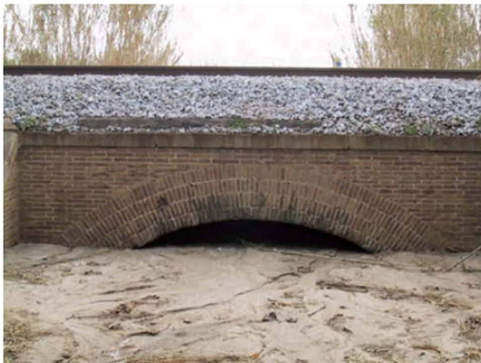
Figura 10. Exemple de pas sota via taponat pel transport de sorres (font: Font et al., 2014).
