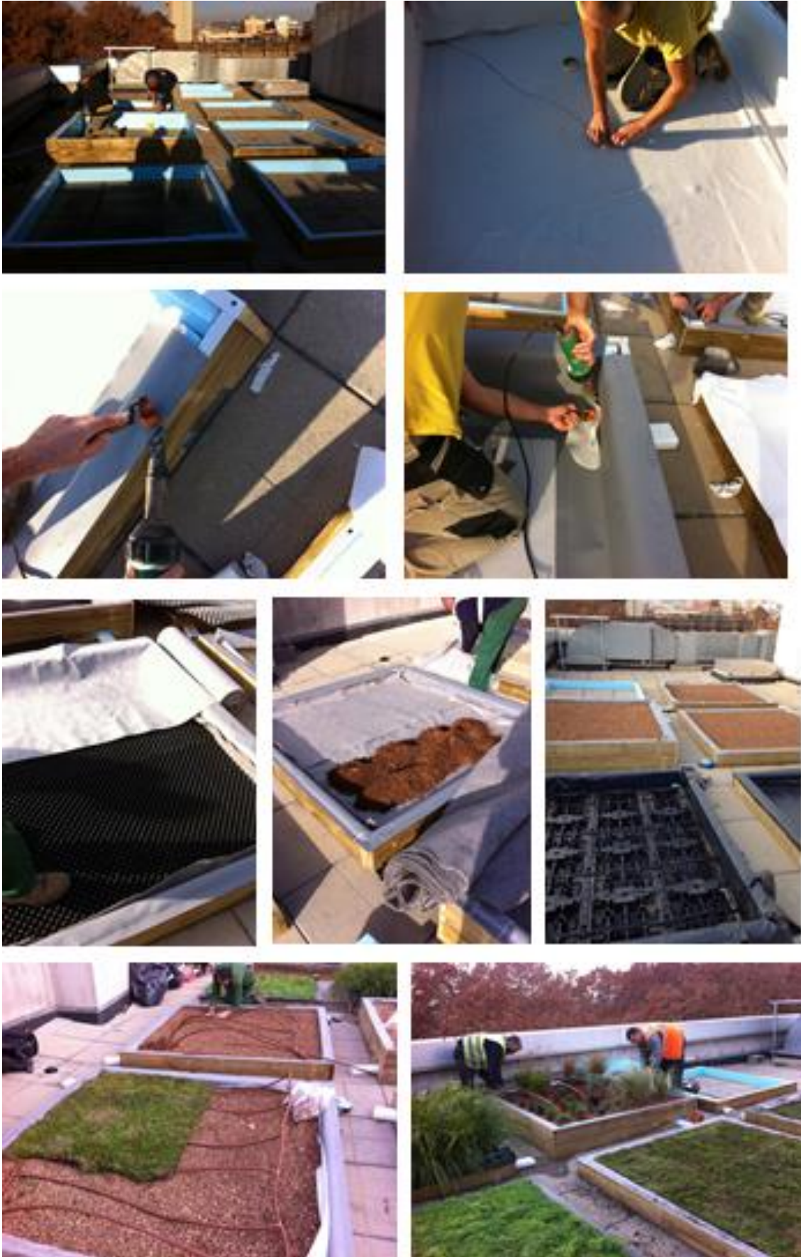
Figura 11. Instal·lació de les mostres a Mercè Rodoreda 23
