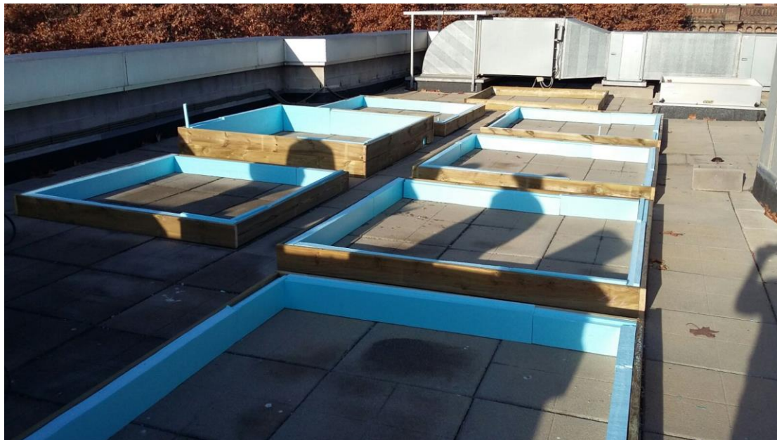
Figura 10. Instal·lació de les jardineres a Mercè Rodoreda 23
