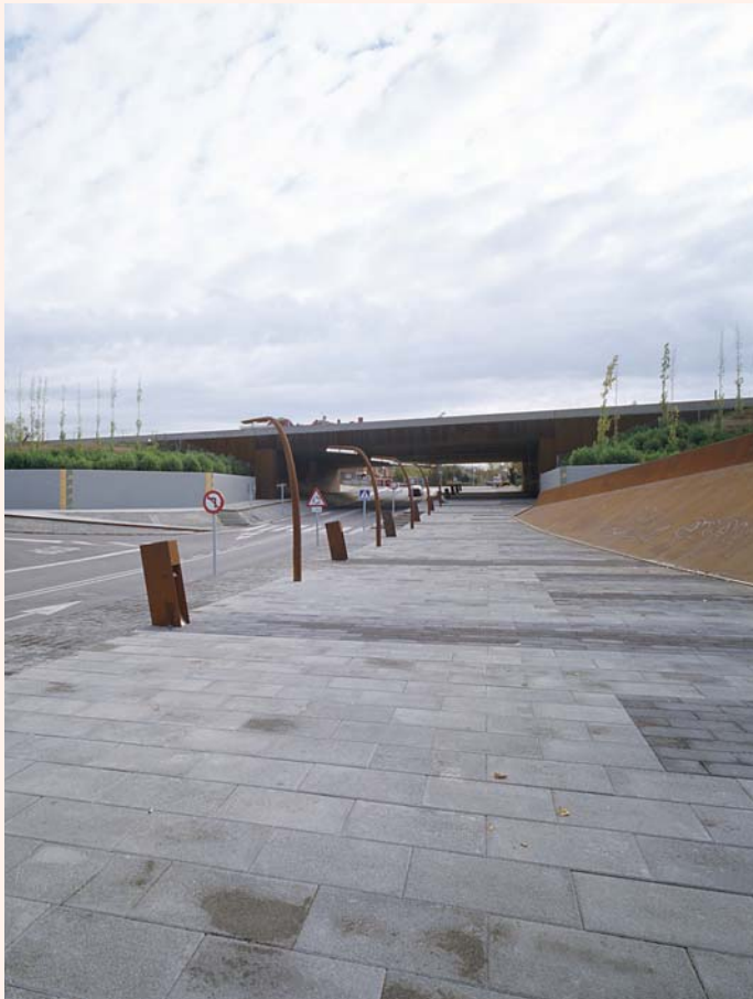
Castelldefels. Pas inferior de l'avinguda de la Ciutat de Màlaga
