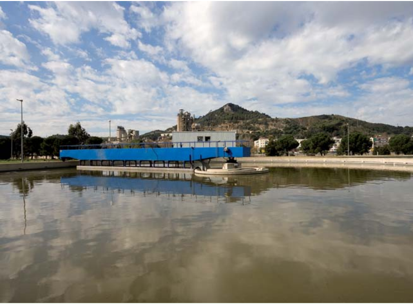
EDAR Montcada i Reixac
