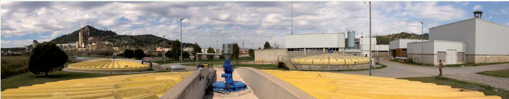
EDAR Montcada i Reixac
