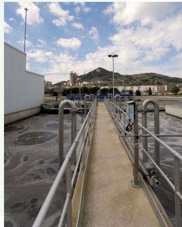
EDAR Montcada i Reixac
