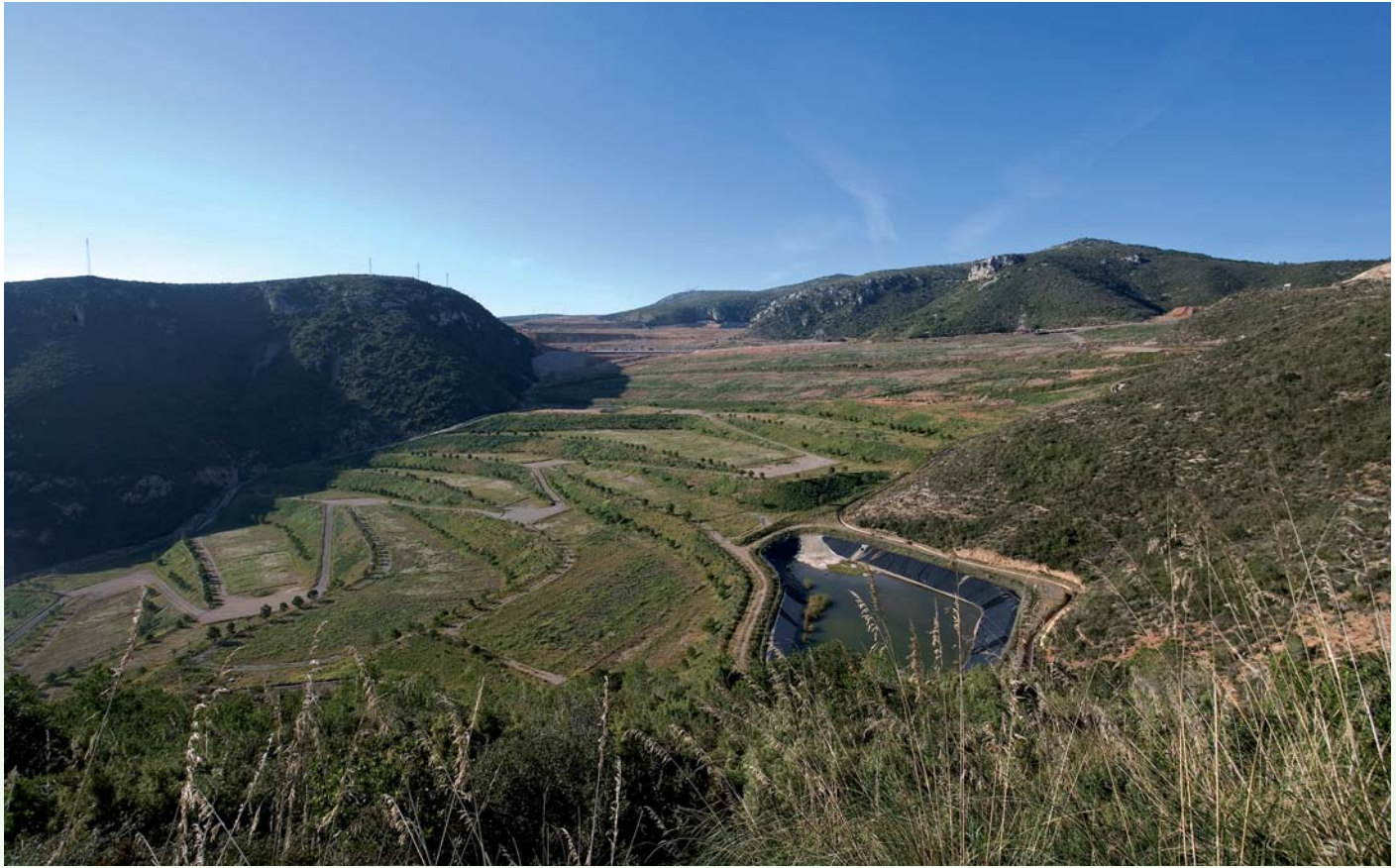
Vista general del dipòsit restaurat
