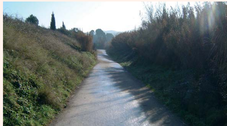
Manteniment del camí de Can Borrell. Sant Cugat del Vallès
