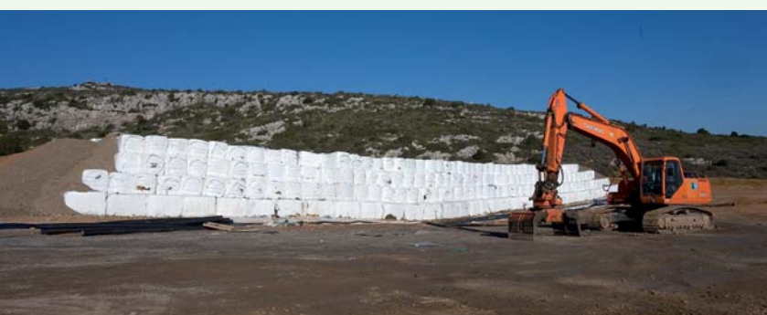
Prova pilot de disposició de residus en bales
