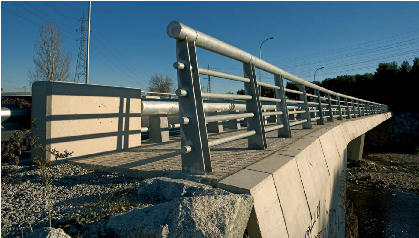
Badia del Vallès. Pont sobre el riu Sec
