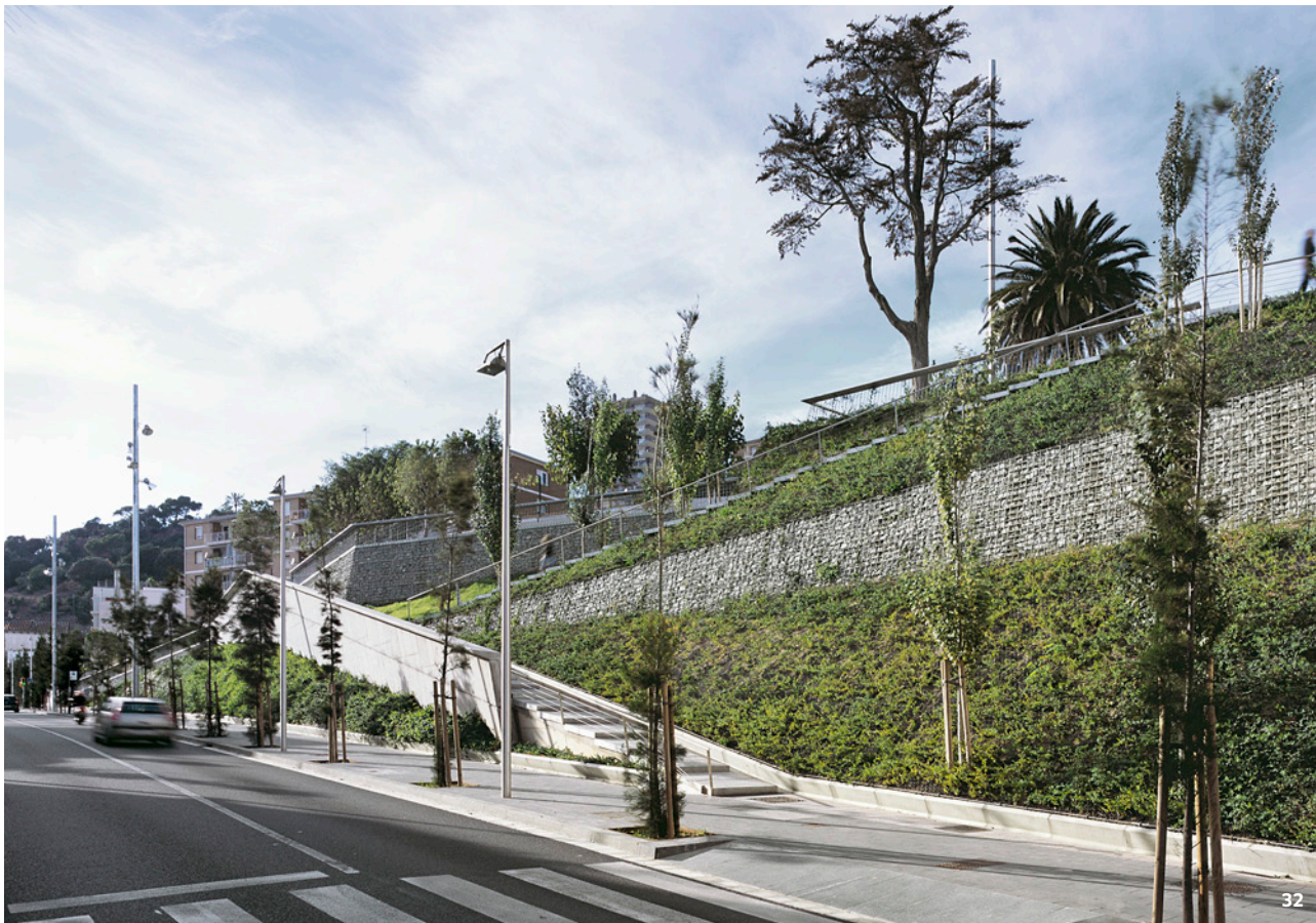
32. Urbanització de la carretera N-II al seu pas per Montgat.
